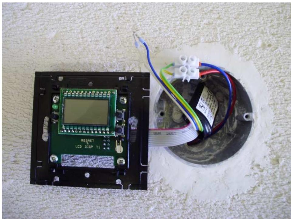
Instalační krabici zakryjte panelem s LCD displejem a upevněte ho pomocí šroubů k instalační krabici.
